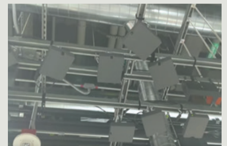
2. All'interno ci sono centinaia di telecamere e sensori
