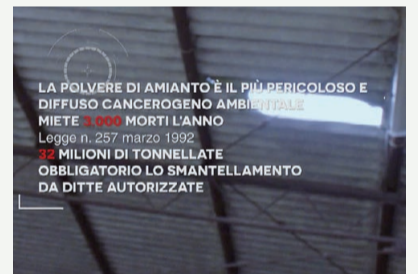
Il rivestimento dell'allevamento è ancora in eternit
