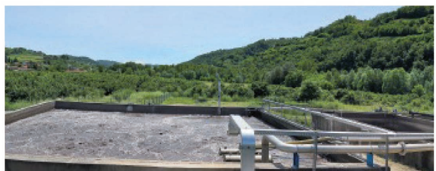
REATTORI A FANGHI ATTIVI CON FUNZIONAMENTO A CICLO DISCONTINUO "SBR"
