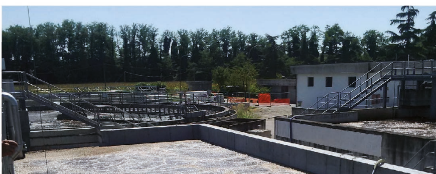
IMPIANTI DI DEPURAZIONE A FANGHI ATTIVI A SCHEMA CLASSICO
