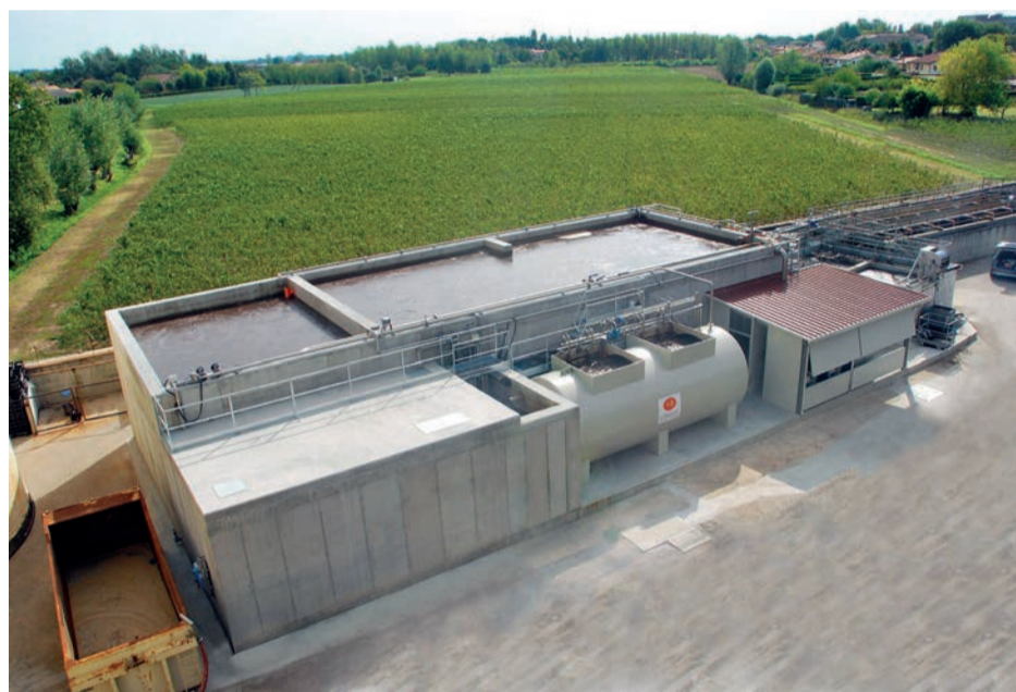
Impianto biologico a tecnologia Mbr, con membrane di ultrafiltrazione in reattore Ecoblock. Installazione presso Conselve Vigneti e Cantine, Conselve (Pd).
