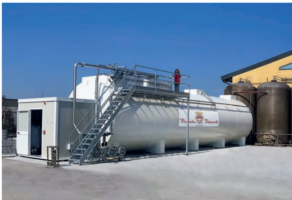
Impianto biologico a tecnologia Mbr Serie Ecoblock, per trattamento reflui da attività di imbottigliamento. Installazione presso Vinicola Decordi, Motta Baluffi (Cr).
