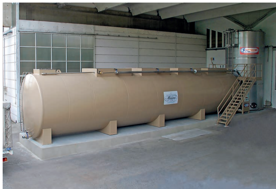
Impianto biologico a tecnologia Mbr Serie Ecoblock, per trattamento reflui da attività di imbottigliamento. Installazione presso Cantine Francesco Minini, Verolanuova (Bs).
