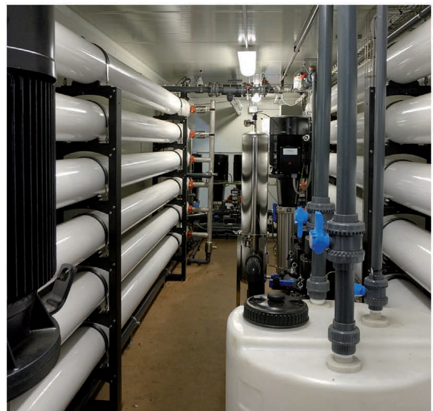
IMPIANTI PER TRATTAMENTO ACQUE PRIMARIE
